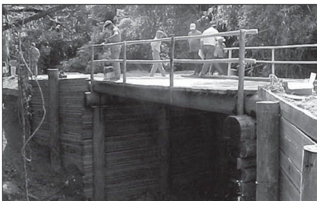
Figura 1 Ponte em viga de madeira roliça (Ponte Estrada Floresta).
