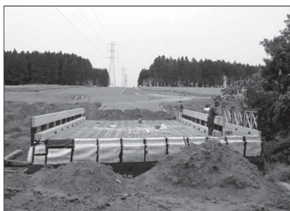
Figura 11 Ponte em placa multicelular protendida (Ponte P03 – USP).
